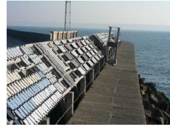
Fotoğrafın kaynağı: “Institut de la Corrosion”
